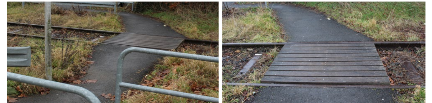
Übergang der Bahnschienen Kindergarten St. Mauritius
