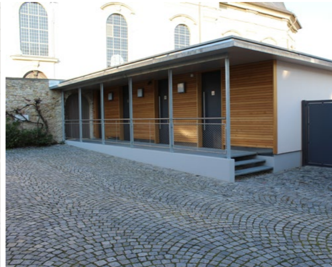
Toilettenanlage an der Mauritiuskirche
