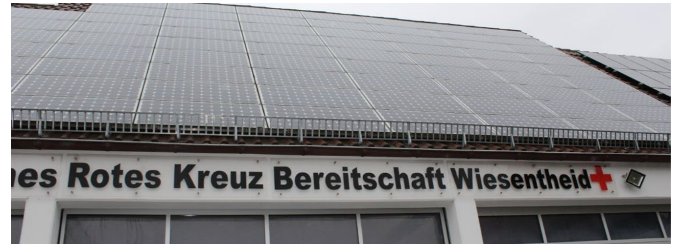
Photovoltaikanlage der Bürgerenergiegenossenschaft auf dem alten Feuerwehrhaus
