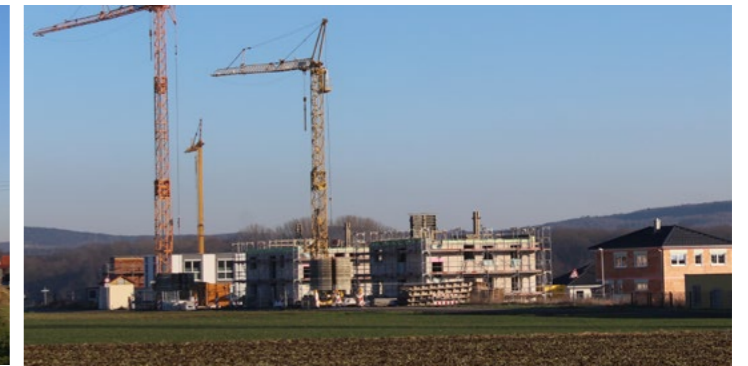
rege Bautätigkeit im Baugebiet „Weiherbrunnen“
